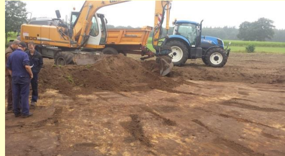
Graafwerkzaamheden voor nieuwe natuur in Wesepe
